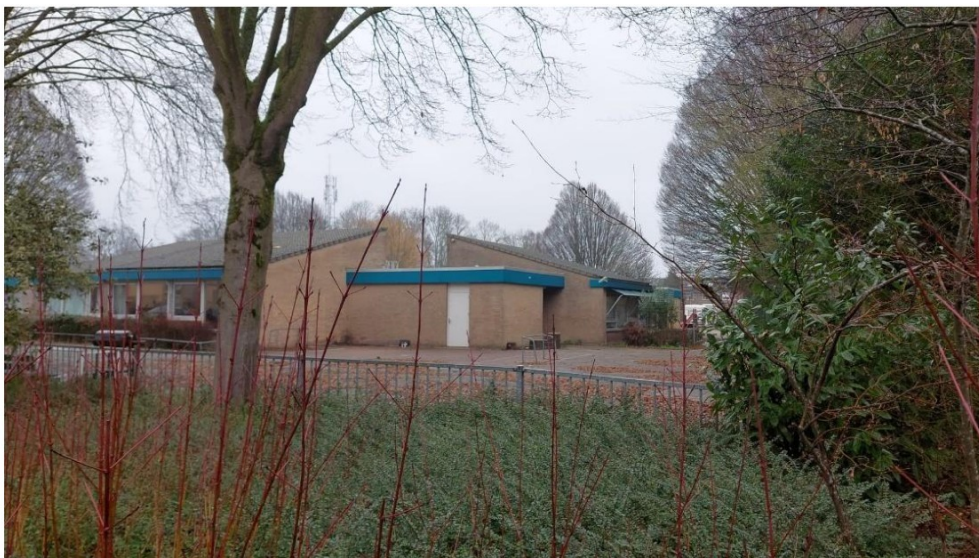
Bestaand gebouw februari 2026 vanuit het zuiden (bron: sab).
