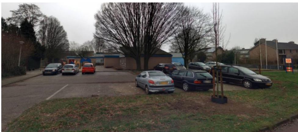
Parkeerruimte noordzijde (bron: cyclomedia).
