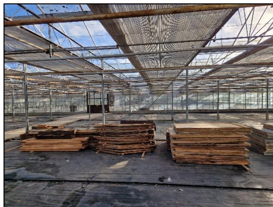
Fig. 2.5, Binnenzijde van kassen (bron: FF Solutions)
