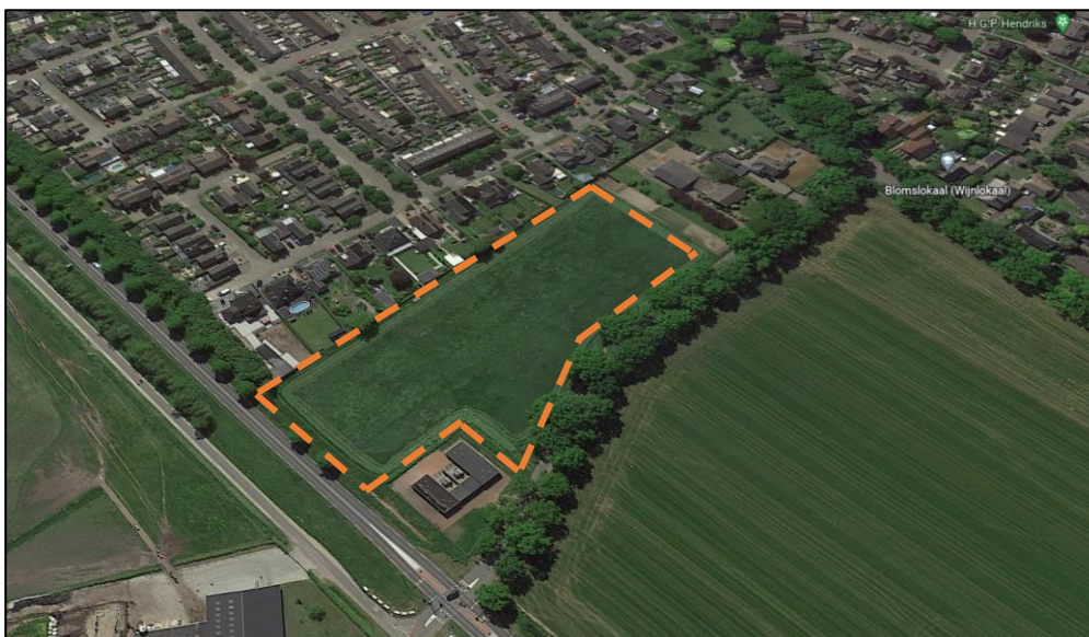
Luchtfoto van het plangebied, gezien vanuit noordelijke richting, met de globale begrenzing aangeduid met een rode stippellijn (bron: Google Earth).
